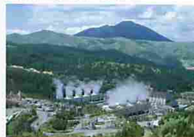
八丁原地熱発電所(大分県九重町)
