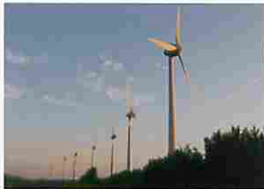
能代風力発電所(秋田県能代市)
